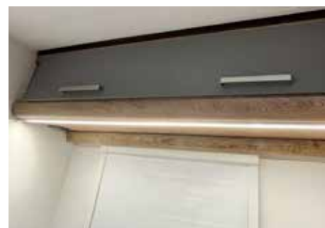
Interiérové LED osvětlení.
